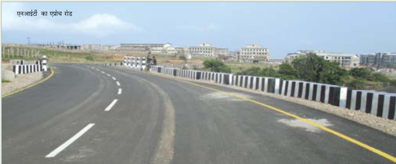
एनआईटी के एप्रोच रोड के पुल का निरीक्षण
