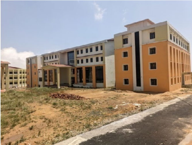
शैक्षणिक भवन - C
